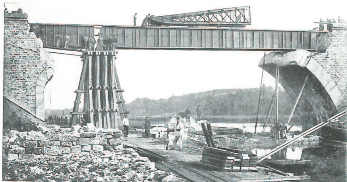
Pont de Trilport. — Pont provisoire Marcille, repliement de l'avant-bec (Septembre 1914)
